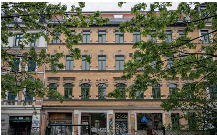
Merseburger Str. 17. Seit 2018 im Eigentum der SoWo. Bauarbeiten begleiteten die Bewohner eine ganze Zeit. Bilanz: Auch mit Eigenleistungen saniert. Neue Wohnräume im Dachgeschoss geschaffen, die Rückseite gedämmt, neue Fenster, Elektrik und Sanitärräume gebaut. Und im Hinterhof gibt es inzwischen einen Kräuter- und Gemüsegarten.
