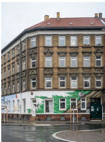
Wigandstr. 52. Im März 2020 ging das Haus an die Genossenschaft und die Hausgemeinschaft über. Es steht in einem Milieuschutzgebiet. Die geplanten Grundrissänderungen erforderten deshalb langwierige Verhandlungen mit den Ämtern.
